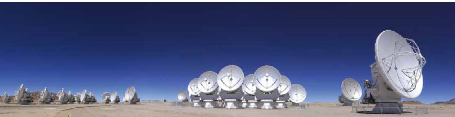
26 アルマ望遠鏡のACA（中央の密集した7mアンテナ群）と周囲の広い領域に配置される多くの12mアンテナ。
