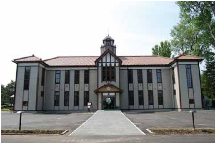
図04 旧緯度観測所本館（奥州宇宙遊学館）。
