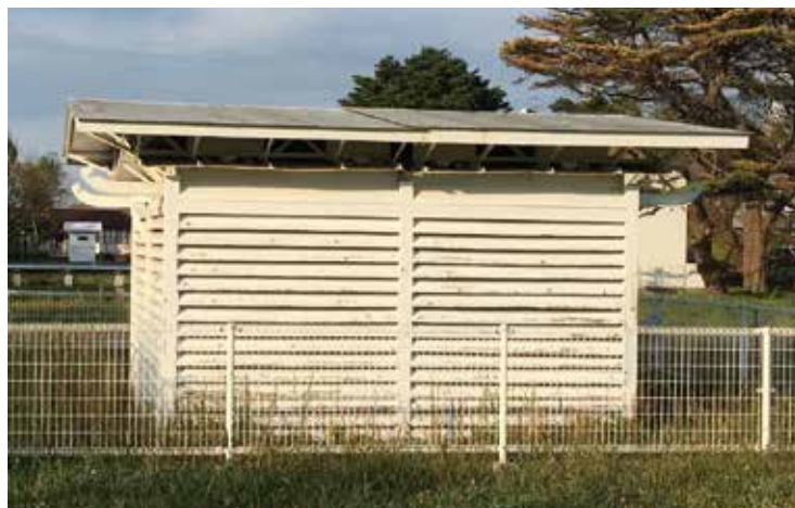
図02a 旧臨時緯度観測所眼視天頂儀室。左遠方に、目標台及び覆屋が見える。
