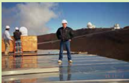
1995年11月。建設中のすばる望遠鏡ドームの屋根にて。
