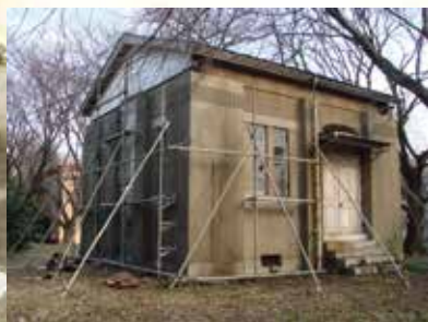
画像08 修復中のレプソルド子午儀室。
