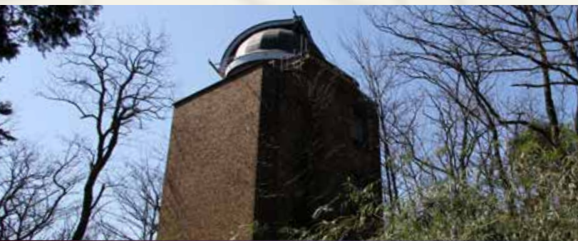
1926年(大正15年)竣工 太陽塔望遠鏡(太陽分光写真儀室)
