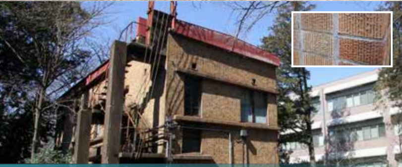
1930年(昭和5年)竣工 旧図書及び倉庫
