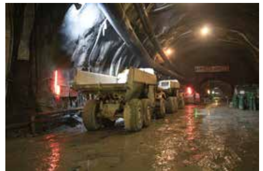
08 岐阜県・神岡鉱山の地下では、急ピッチでKAGRAが設置されるトンネル工事が進んでいます（24ページ）。
