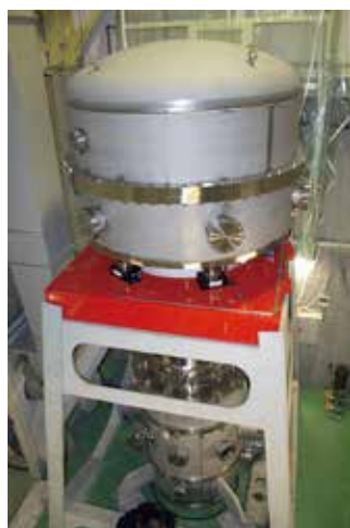
図04 既存のTAMA300の真空槽上部に設置された直径1.5mの真空槽。この中にプレ・アイソレーターが設置されます。
