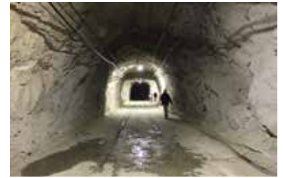
02 CLIOが設置された地下のようす。飛騨片麻岩と呼ばれる硬い地層の中であり地面振動は三鷹の100分の1と、たいへん静かな環境です。
