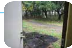
部屋の上部には地上との出入口がある。
