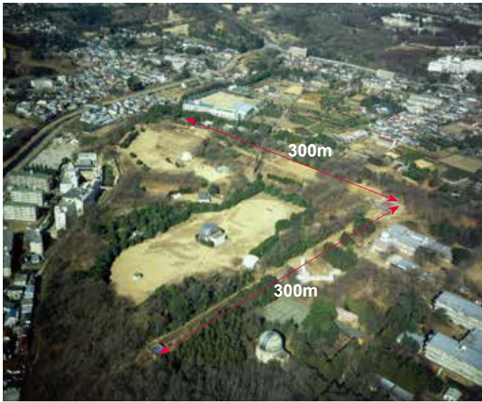
01 国立天文台（三鷹）に設置されたTAMA300。建設時の航空写真で、干渉計のL字型の光路用のトンネル（片側の長さが300m）のようすがわかります。
