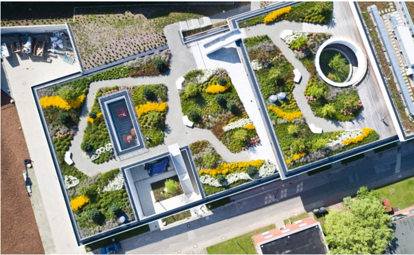
Grünes Dach des MPI für Struktur und Dynamik der Materie.
