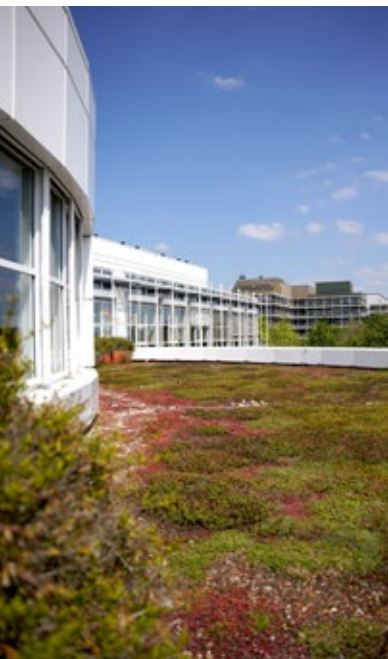
Begr6ntes Dach des MPI f6r Polymerforschung.
