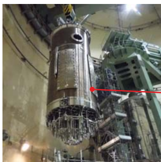
【炉内構造物取替工事】 (CIR)
