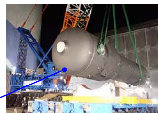
【蒸気発生器取替工事】 (SGR)
