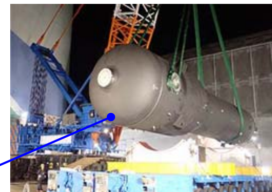
【蒸気発生器取替工事】 (SGR)
