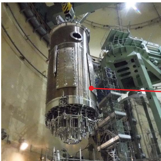
【炉内構造物取替工事】 (CIR)
