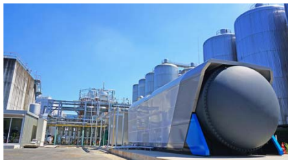
アサヒビール茨城工場導入 バイオメタンガス燃SOFC
