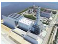
GTCC発電設備
