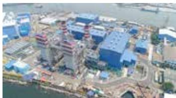
Jawa-2 GTCC Construction Site
