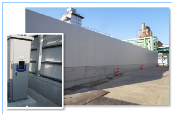
図7 防音壁設置状況
