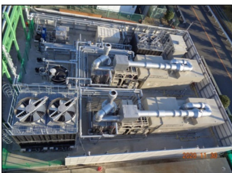
図6 完成写真全景
