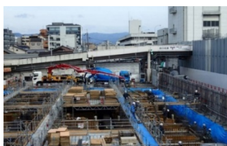
図10 基礎コンクリート打設状況
