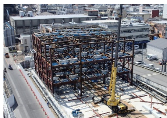
図11 鉄骨建方状況
