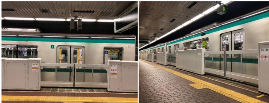
図2 可動式ホーム柵設置状況(新長田駅1番線にて)
