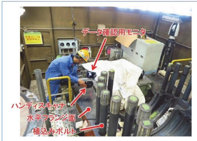
図5 車室フランジ面の3Dレーザ計測の様子
