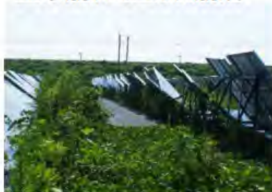
放置されたパネルの現況
