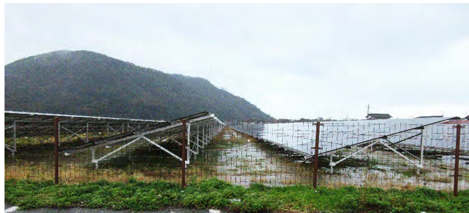
発電施設の外観
