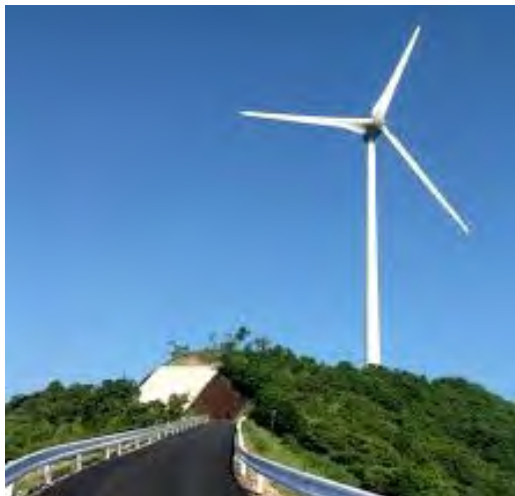
高原に設置された風車 (柳山風車公園)
