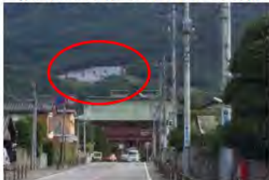
景観を乱すパネルの設置
