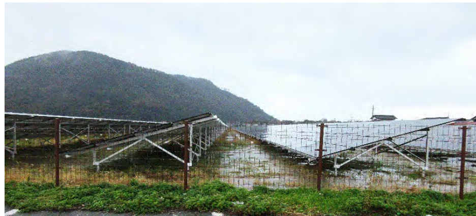
発電施設の外観
