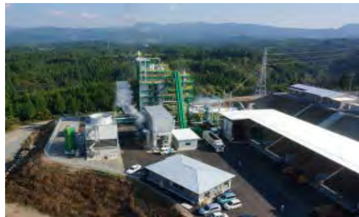
発電施設の外観
