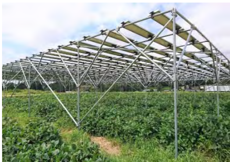
発電設備の外観
