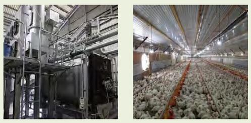
・鶏糞を燃料とするバイオマスボイラーを導入し、温水熱を活用した温風暖房を鶏舎内に配置することで、従来のLPガスによる暖房費を4分の1に低減。
