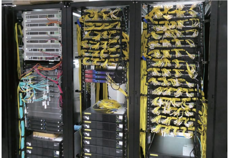
コアスイッチ群には、フォーティネットのグループ企業である アラクサラネットワーク製のAX8600S、AX3660Sが導入されている。
