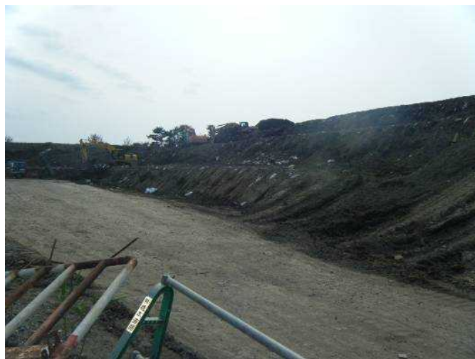
土壌改良され保管された津波堆積物
