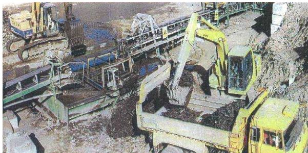
水槽分離施設での作業の様子
