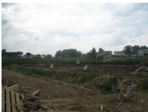
災害廃棄物撤去現場の状況 1
