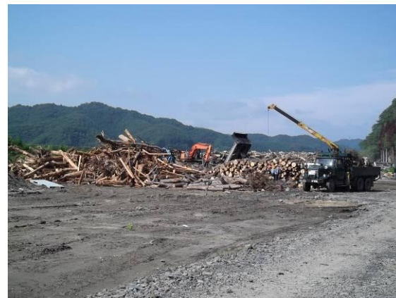
鵜住居地区仮置場（木材）
