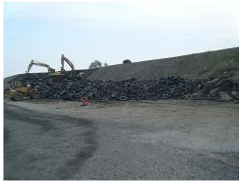
搬入場の状況（廃タイヤ）
