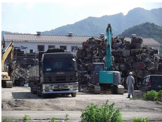
片岸地区仮置場（金属類の搬出）
