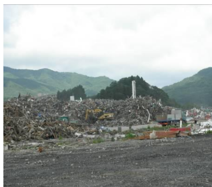
重機分別作業状況
