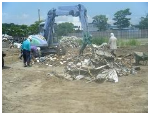
仮置場(新浜町公園)の状況(分別作業)
