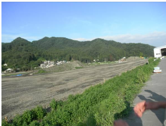
沢山地区仮置場（整備中）
