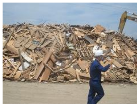
仮置場の状況（木質系がれき）
