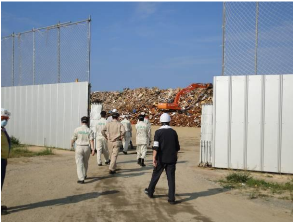
仮置場全周を 3mH の囲いとネットで囲っている
