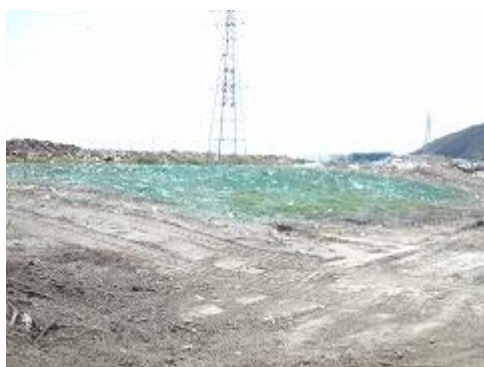
仮置場の状況（粉塵対策）
