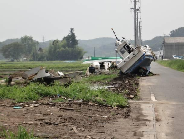
鹿島区真野小学校付近（船舶撤去困難）の写真
