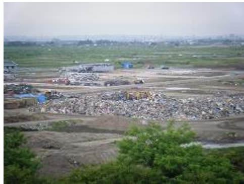
搬入場の状況 1
