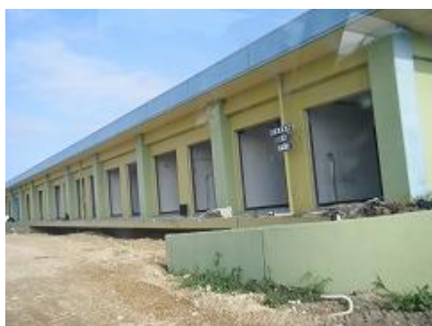
仮置場状況（有害物・危険物）
