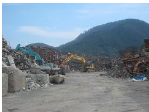
仮置場の状況（コンクリート、金属）
