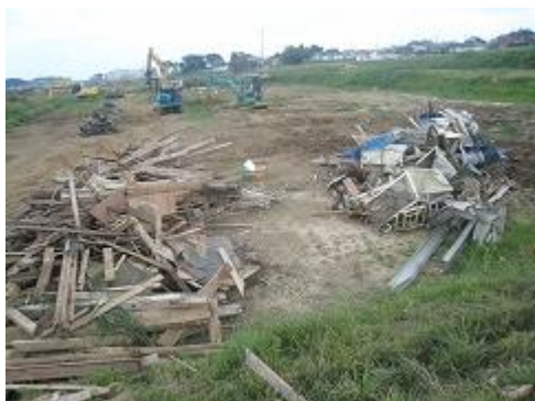
災害廃棄物撤去の状況 3
