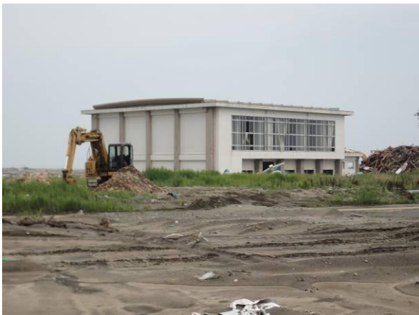
倒壊を免れた体育館
