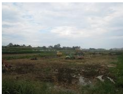
災害廃棄物撤去現場の状況 2
