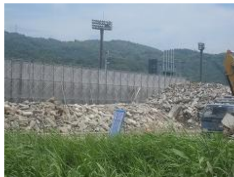
仮置場の状況（コンクリート殻）
