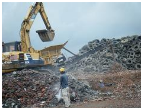
小塚原地区仮置場(散水による飛散防止)
