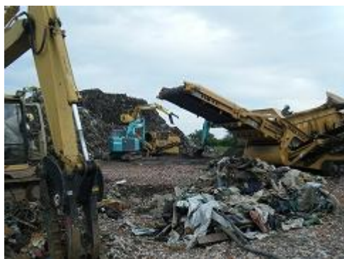
小塚原地区仮置場状況
