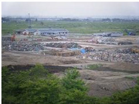
搬入場の状況 2
