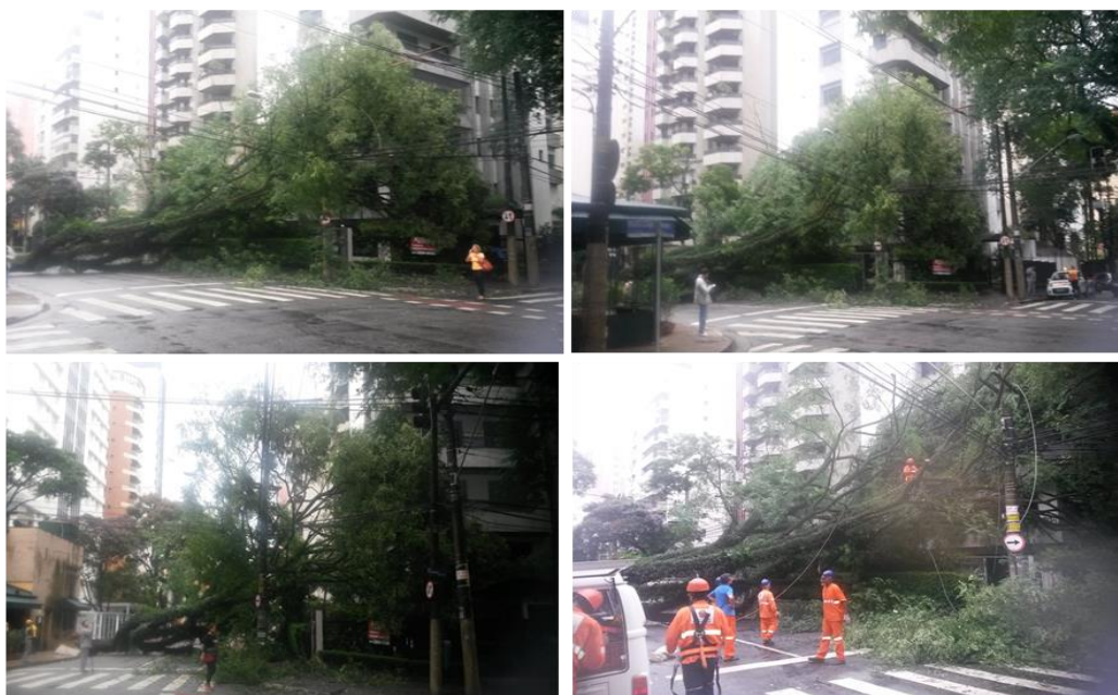
Queda de uma árvore de grande porte sobre a rede deixando fio de alta tensão partido na Rua Pintassílgo, 185 Moema São Paulo SAM-0104
