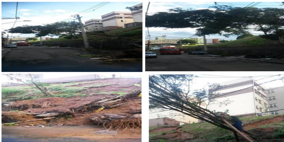
Queda de uma árvore de grande porte sobre a rede deixando fio de alta tensão partido na Rua Flôr da Madrugada, 76 Sapopemba São Paulo MAT-0112
