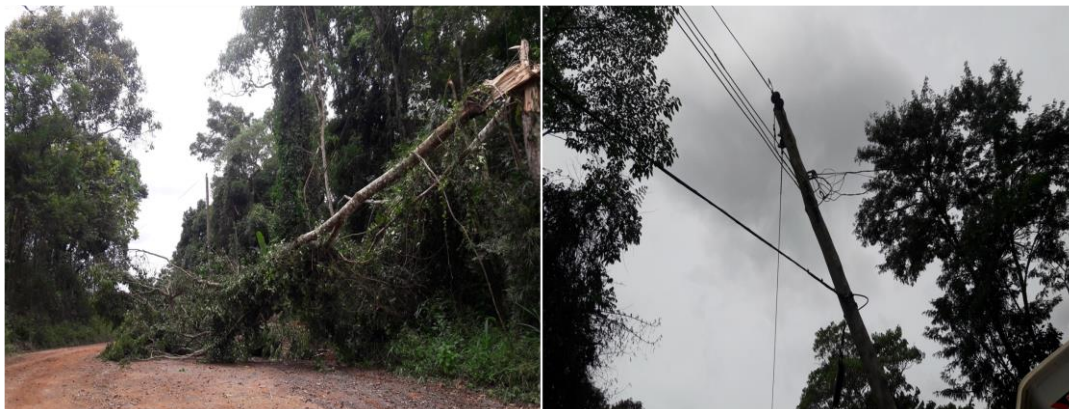
Queda de uma árvore de grande porte sobre a rede deixando fio de alta tensão partido na Est Gracilina Vaz Pires de Oliveira 333
