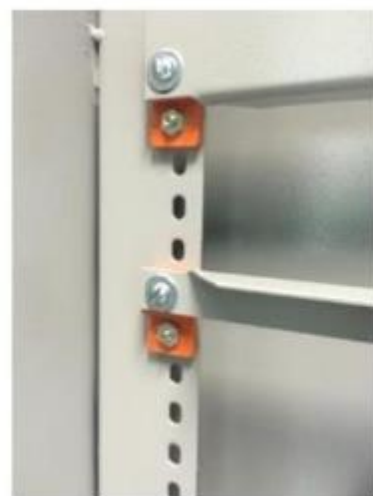
Figura 2: Detalhe da longarina e aplicação dos isoladores
