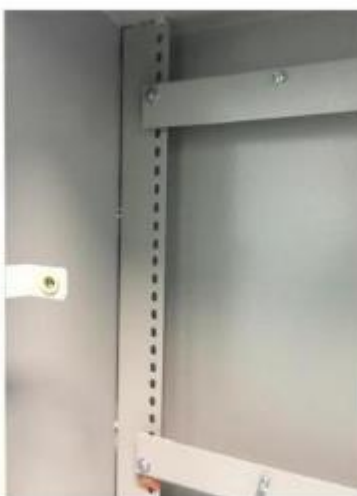
Figura 2: Detalhe da longarina e aplicação dos isoladores
