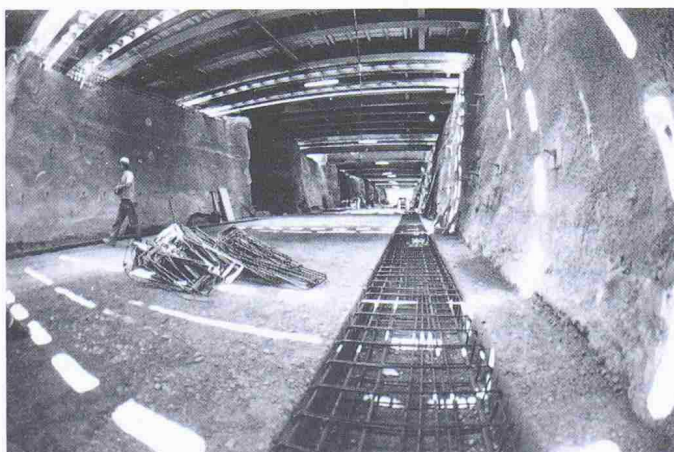
Bild 3. Vernagelte Steilwand und Hilfsbrücken
