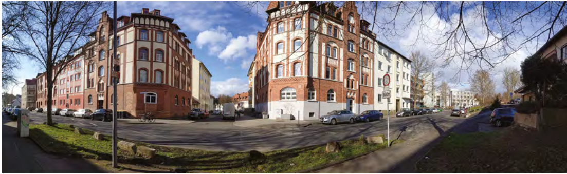
Abbildung 9.4: Bebaute Umgebung der Quellhofstraße, Kassel
