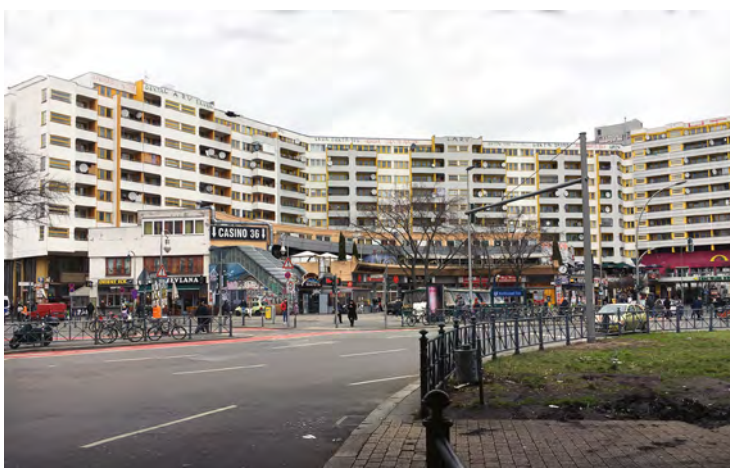
Abbildung 9.3(a): NKZ-Gebäude in Berlin
