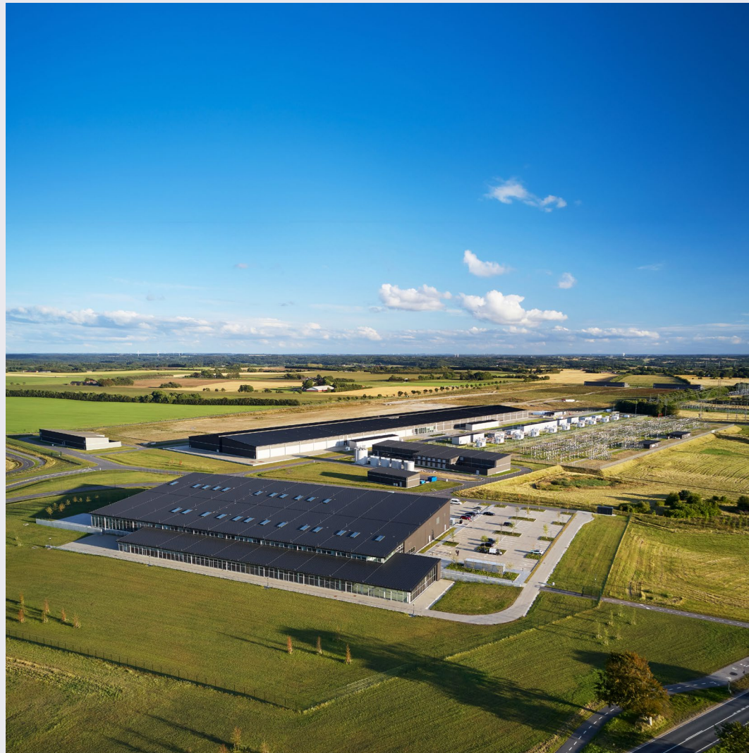
我们的丹麦维堡数据中心于 2023 年成为第三家获得 TRUE 白金认证的设施, 即该场所超过 90% 的废弃物都被回收利用、制成堆肥或得到重复使用。
