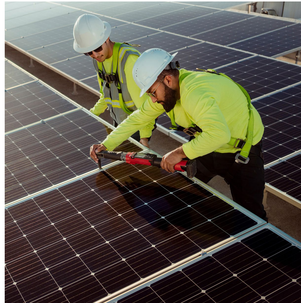
Simmitri 的技术人员对位于加利福尼亚州 Santa Clara 的 Bench-Tek Solutions 公司安装的太阳能面板开展维护工作。这两家公司都参加过 Apple Impact Accelerator 项目。
