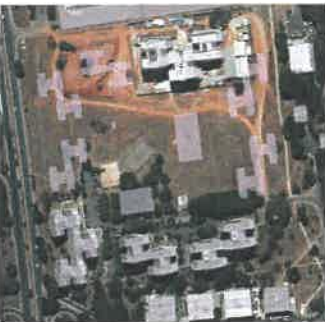
Figura 14 – SQN 204: vista aérea destacando os lotes registrados em cartório
