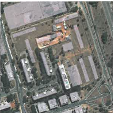
Figura 13 – SQN 114: vista aérea destacando os lotes registrados em cartório
