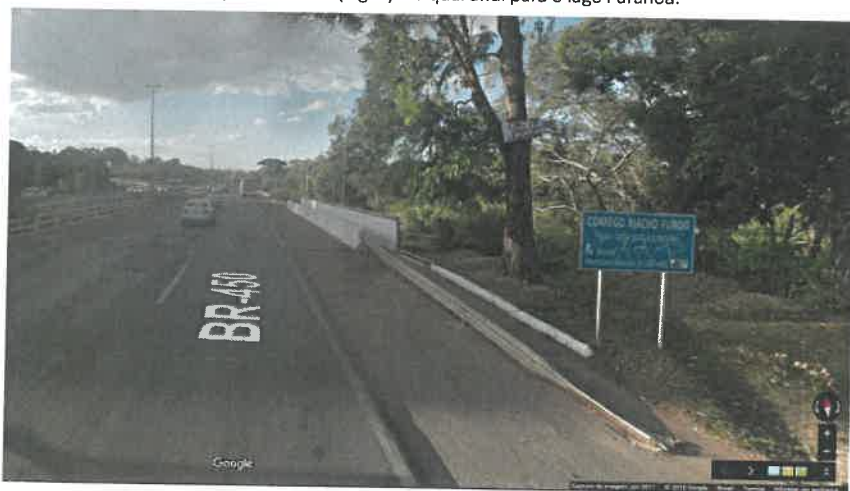
Figura 2 – Ponte da Estrada-Parque Indústria e Abastecimento (EPIA) sobre o córrego Riacho Fundo, limite sul do Conjunto Urbanístico de Brasília Fonte: Google Maps (maps.google.com)
