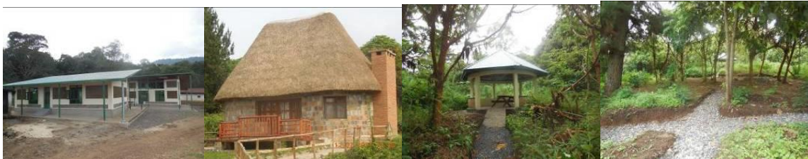
Photos 7,8,9, 10. Respectivement :Bureaux administratifs, Bungalow et Campings
