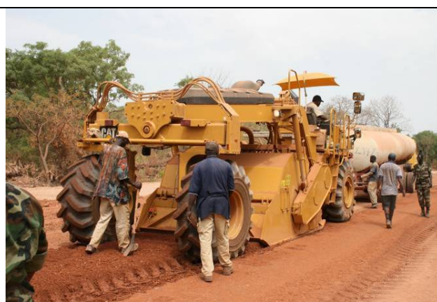
Travaux de la route près de Kalifourou (extérieur du parc)
