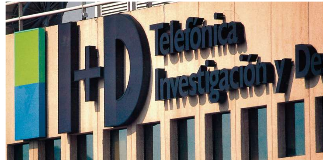
1988. Detalle de la fachada del edificio de Telefónica I+D en la calle Emilio Vargas en Madrid.
