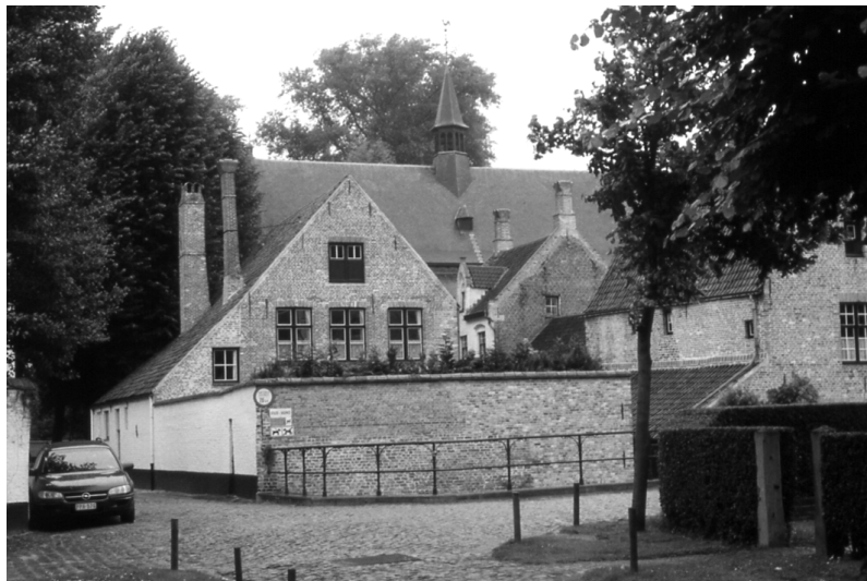
Abbildung 53 (Brugge, K5) Blick auf die rückwärtige Fassade von Haus 11. Im Hintergrund ist die Kirche des Beginenhof mit dem Dachreiter erkennbar. Das Gelände säumt den kleinen Kanal, der den Beginenhof in zwei Bereiche teilt und führt zu dem im 19. Jh. erbauten Eingangstor, das auf den Weg entlang dem Minnewater führt. Links von diesem Blickwinkel liegen die Häuser 48 und 50, rechts davon die Häuser 16-17.
