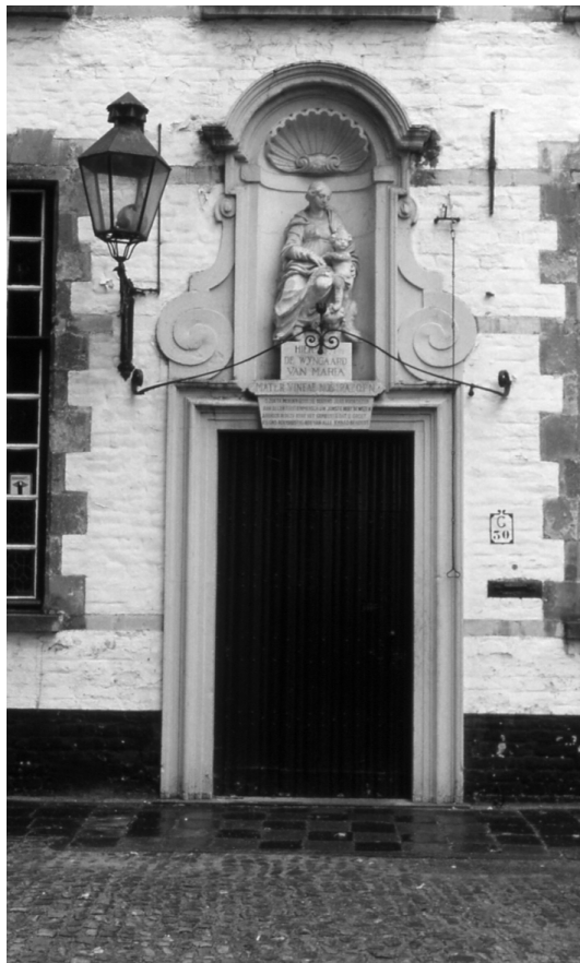
Abbildung 23 (Brugge, K5) Portal des Groothuis im Beginenhof De Wijngaard in Brugge.
