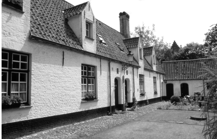
Abbildung 30 (Brugge, K5) Godshuizen des Beginenhof De Wijngaard Brugge.
