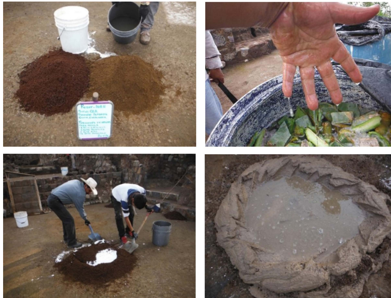
Proceso de elaboración de argamasa de cal con tezontle de San José de los Laureles y tepetate y mucilago de nopal, de San Andrés Cuauhtempan. (Fondo PICZAT 2016).
