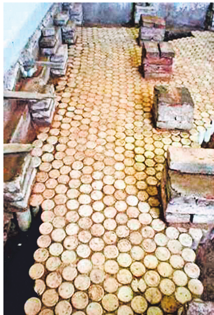
Piso de botellas. Vista superior de un soporte de piso construido con botellas de cerveza reutilizadas.
