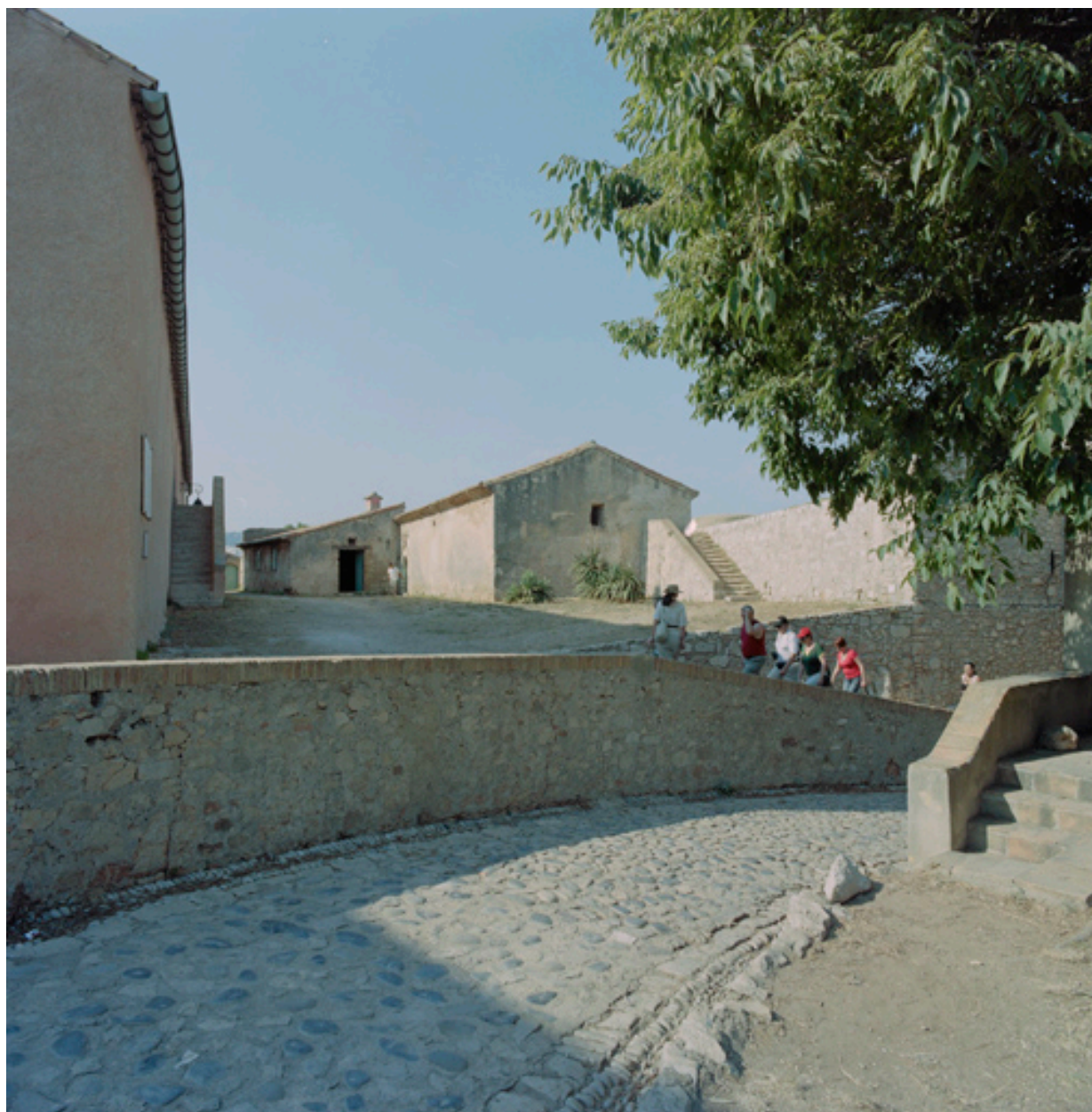
Rampe de la porte Marine, bâtiments o-e et amorce du bâtiment n-d.
