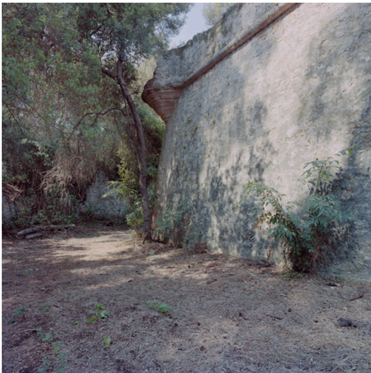
Détail de l'échauguette et du cordon de la demi-lune F (sud-est).
