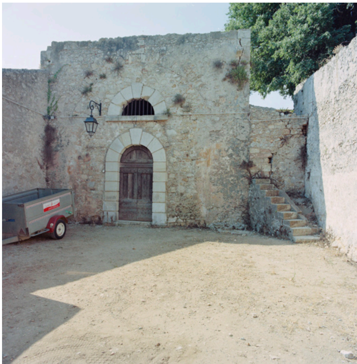
Façade postérieure de de l'abri voûté de l'ancienne porte royale p.
