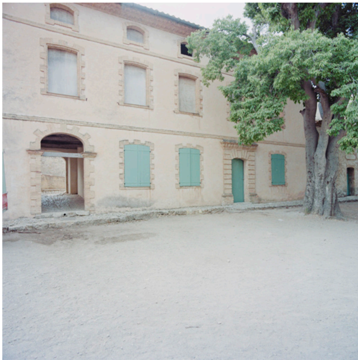
Façade du pavillon de l'officier en chef du génie, bloc W du quartier S-O.
