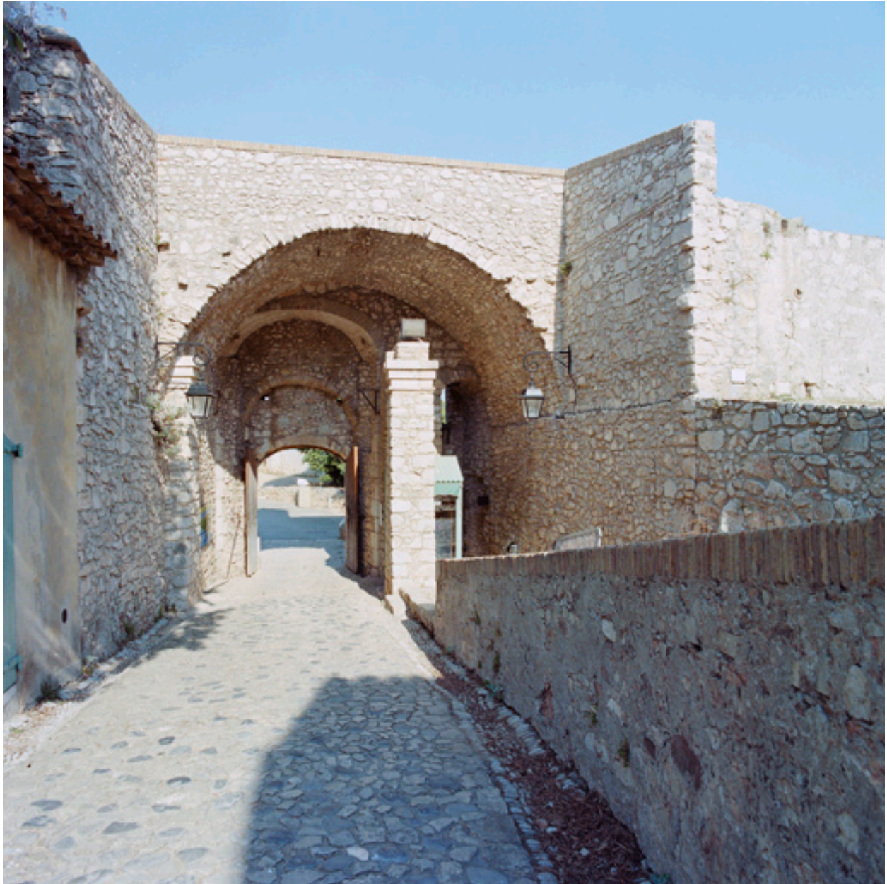
La porte Marine N vue de l'intérieur ; voûte du passage d'entrée et rampes.
