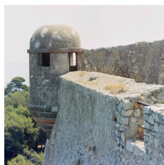
Détail de l'échauguette de capitale du demi bastion C, côté nord.
