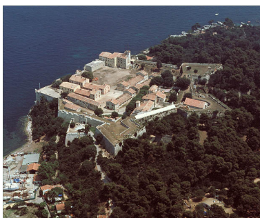
Vue aérienne prise du sud-ouest. Phot. Marc Heller IVR93_19920600265XA
