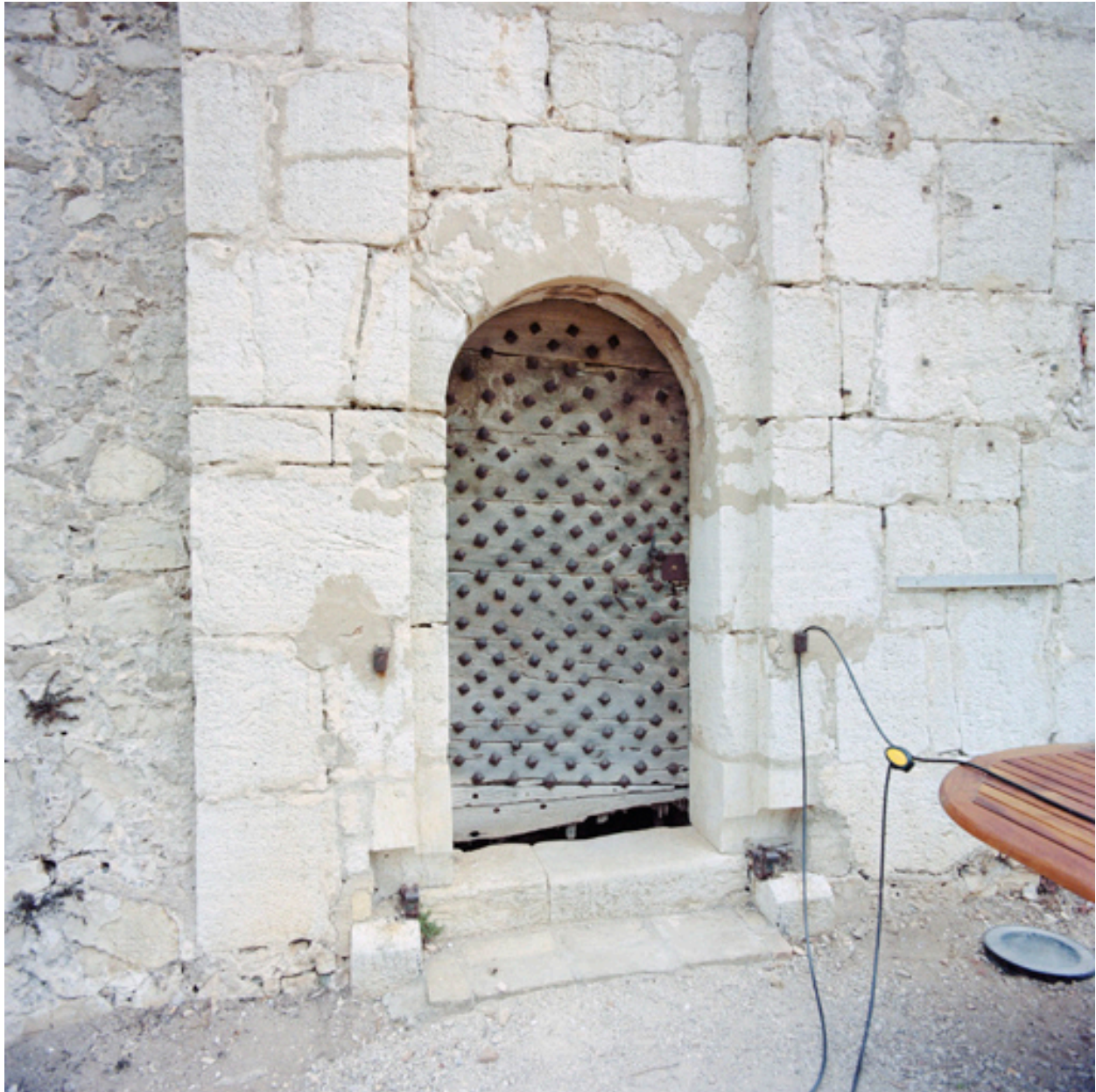
Détail du guichet piéton de la porte Marine M ; vantail d'origine et corbeaux.
