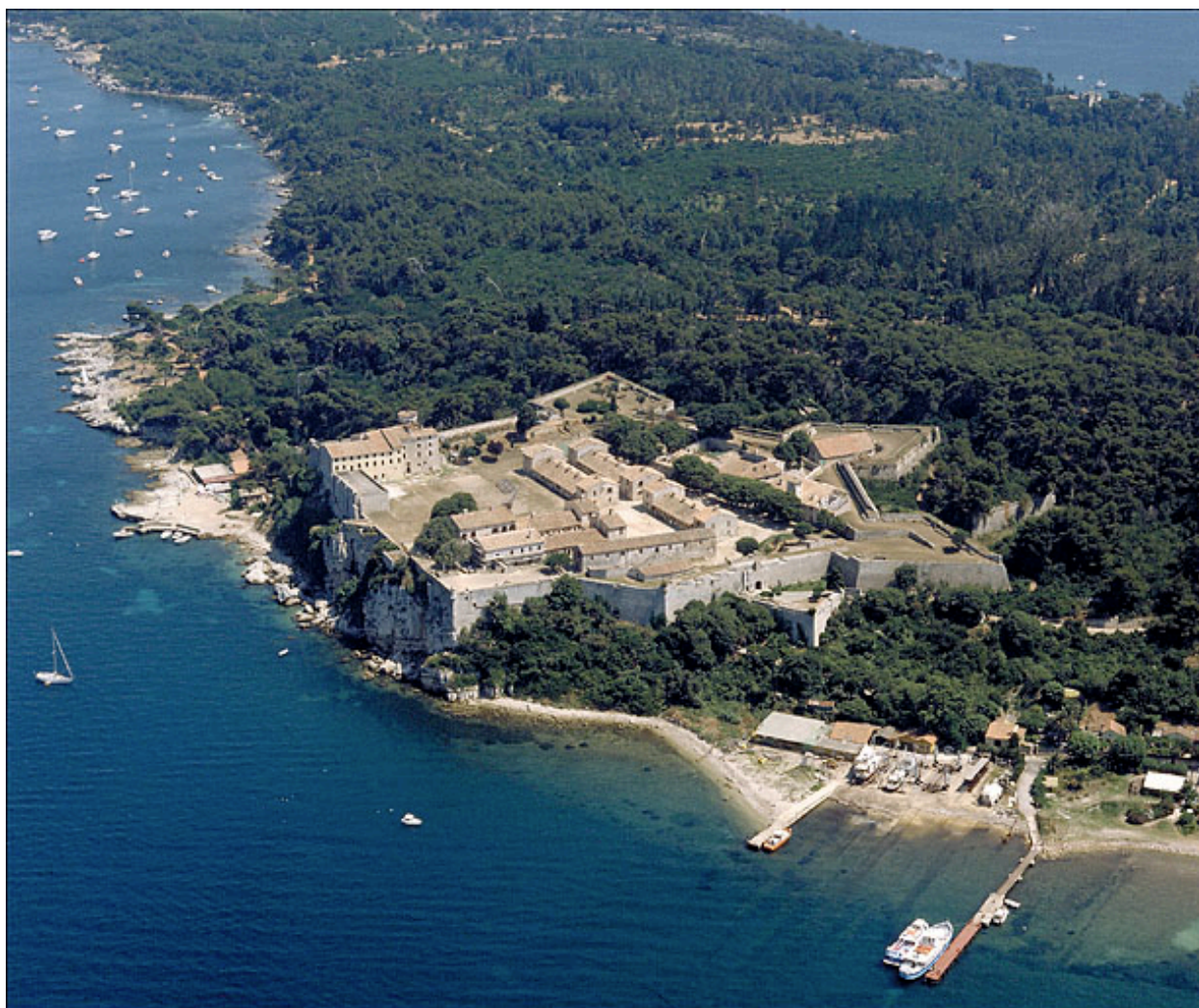
Vue aérienne éloignée prise du nord-ouest.
