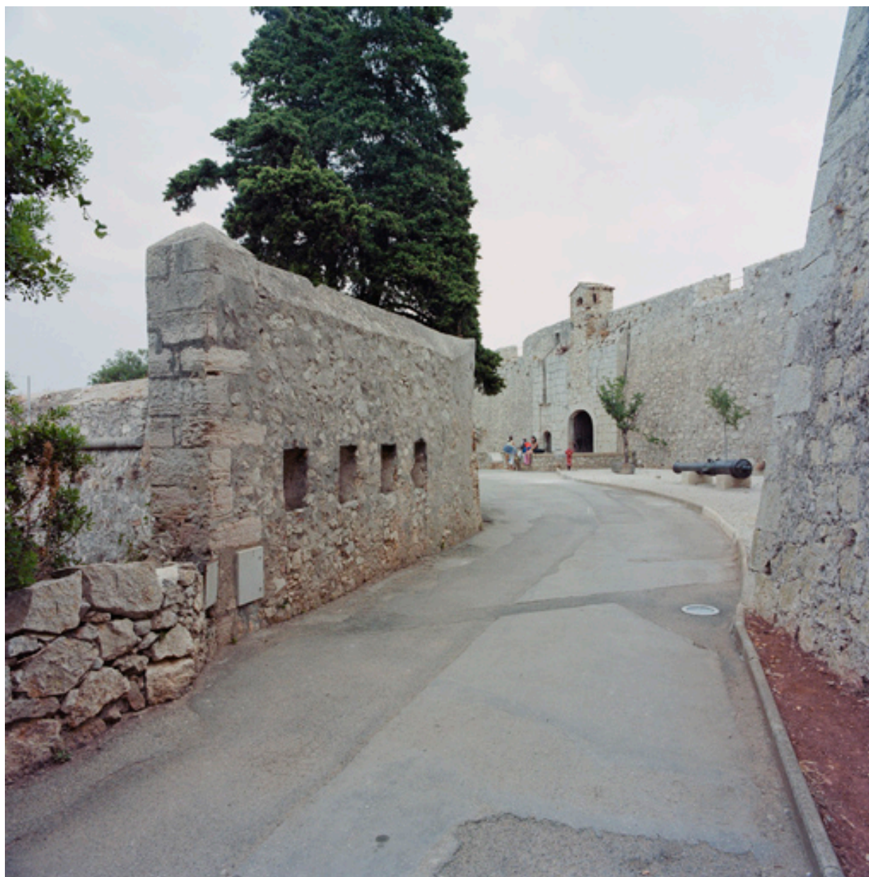
Le front ouest et la porte Marine M vus du chemin du fossé sud-ouest.
