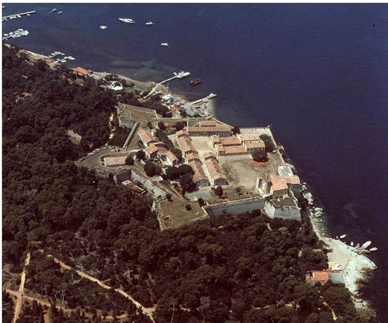
Vue aérienne prise du sud-est.
