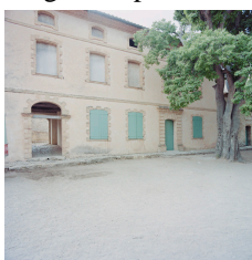
Façade du pavillon de l'officier en chef du génie, bloc W du quartier S-O.
