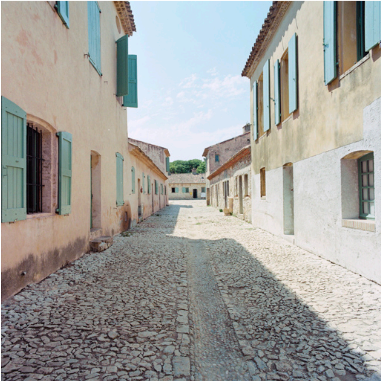
Allée médiane entre les corps de casernes jumeaux X-Y, vers le sud.
