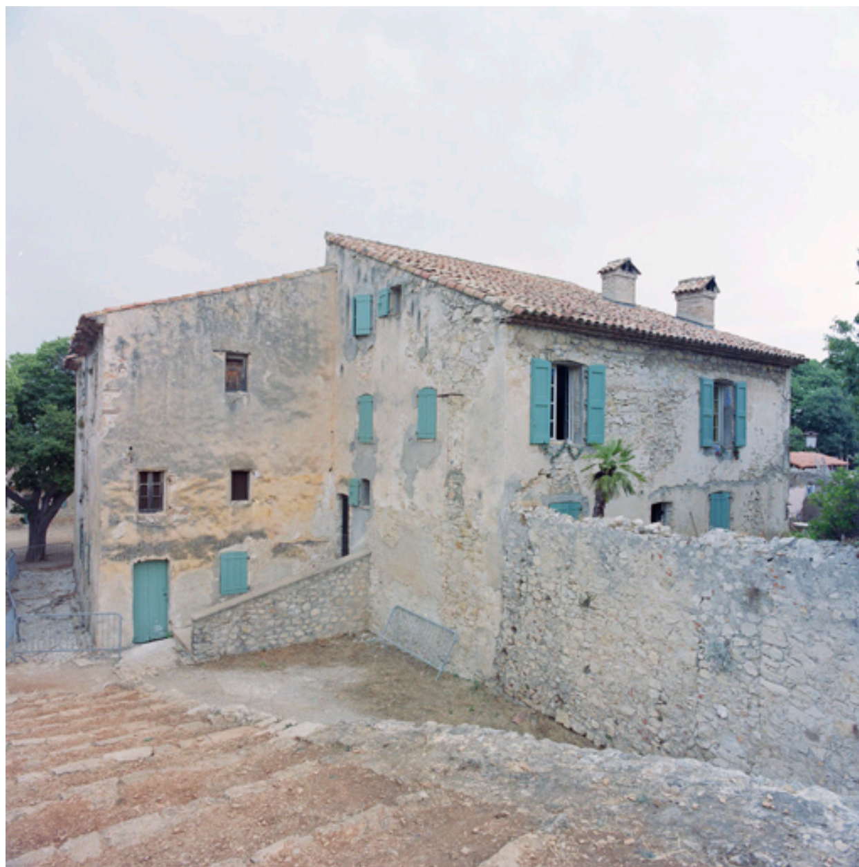
Les deux corps de maison du bloc W, vus de la rampe d'accès au bastion H.
