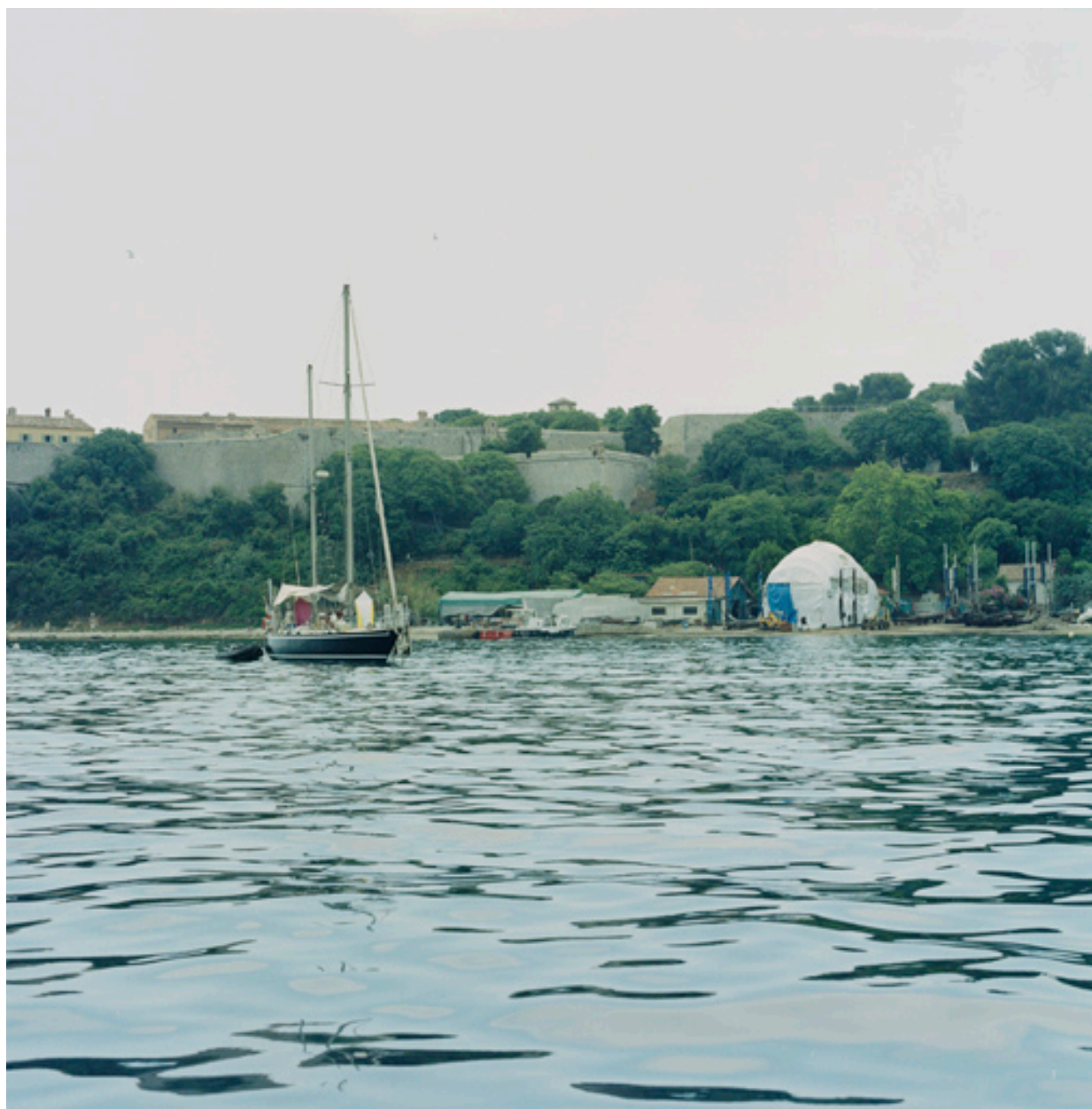
Vue générale du front ouest prise de l'ouest/nord-ouest.
