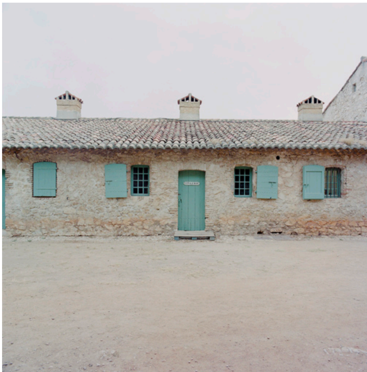
Détail de façade du corps de casernes V.
