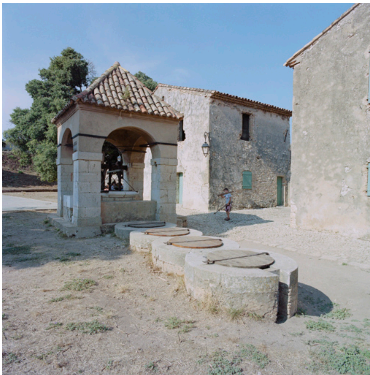
Le puits-citerne (i), avec son édicule de couverture et ses citerneaux.
