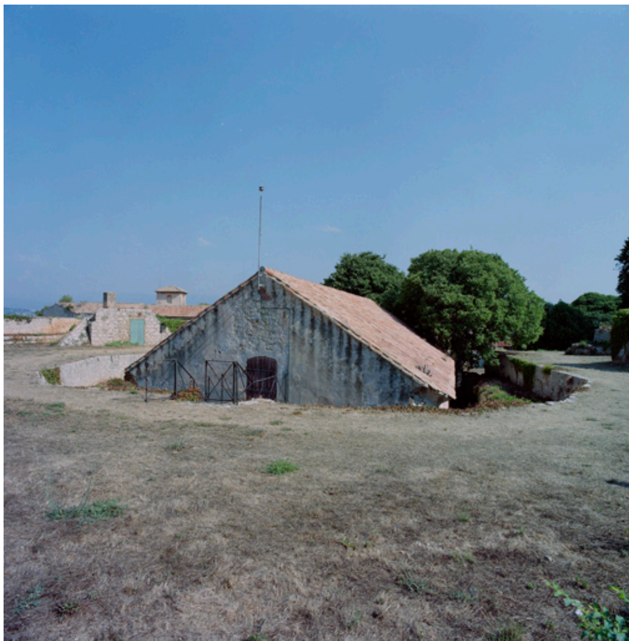
Magasin à poudres R dans le bastion H, vu du sud.
