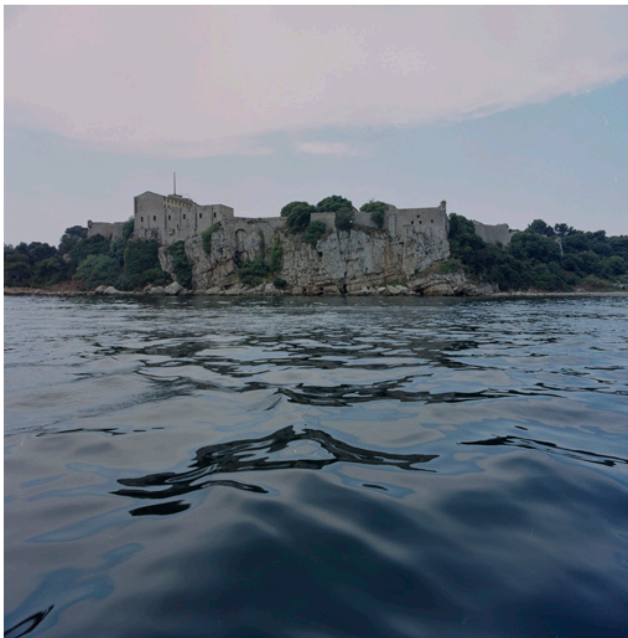
Vue générale du front nord prise depuis la mer.
