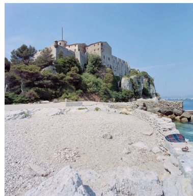
Vue nord-est du fort, bastion C, château A et aile de la prison B. Phot. Marc Heller IVR93_20060600280XE
