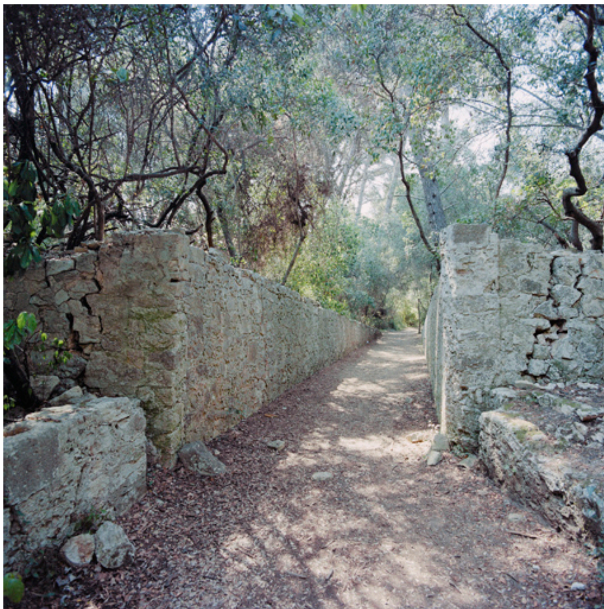
Passage en poterne traversant le chemin couvert et le glacis, front sud.
