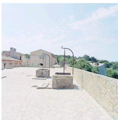
Plate-forme P dite des citernes, au nord-ouest du fort, et bâtiment n. Phot. Marc Heller IVR93_20060600282XE
