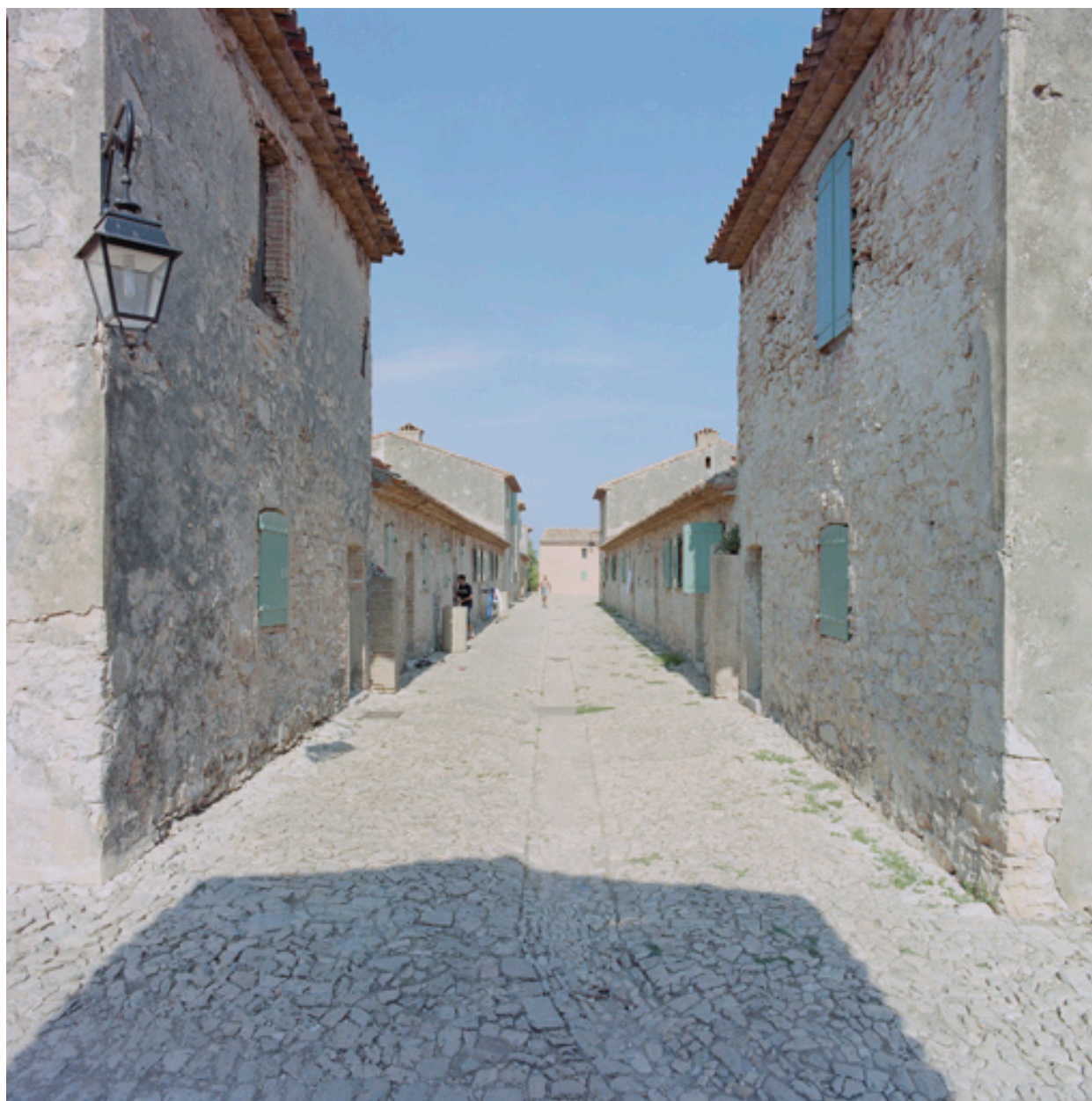
Allée médiane entre les corps de casernes jumeaux S-T, vers l'ouest.
