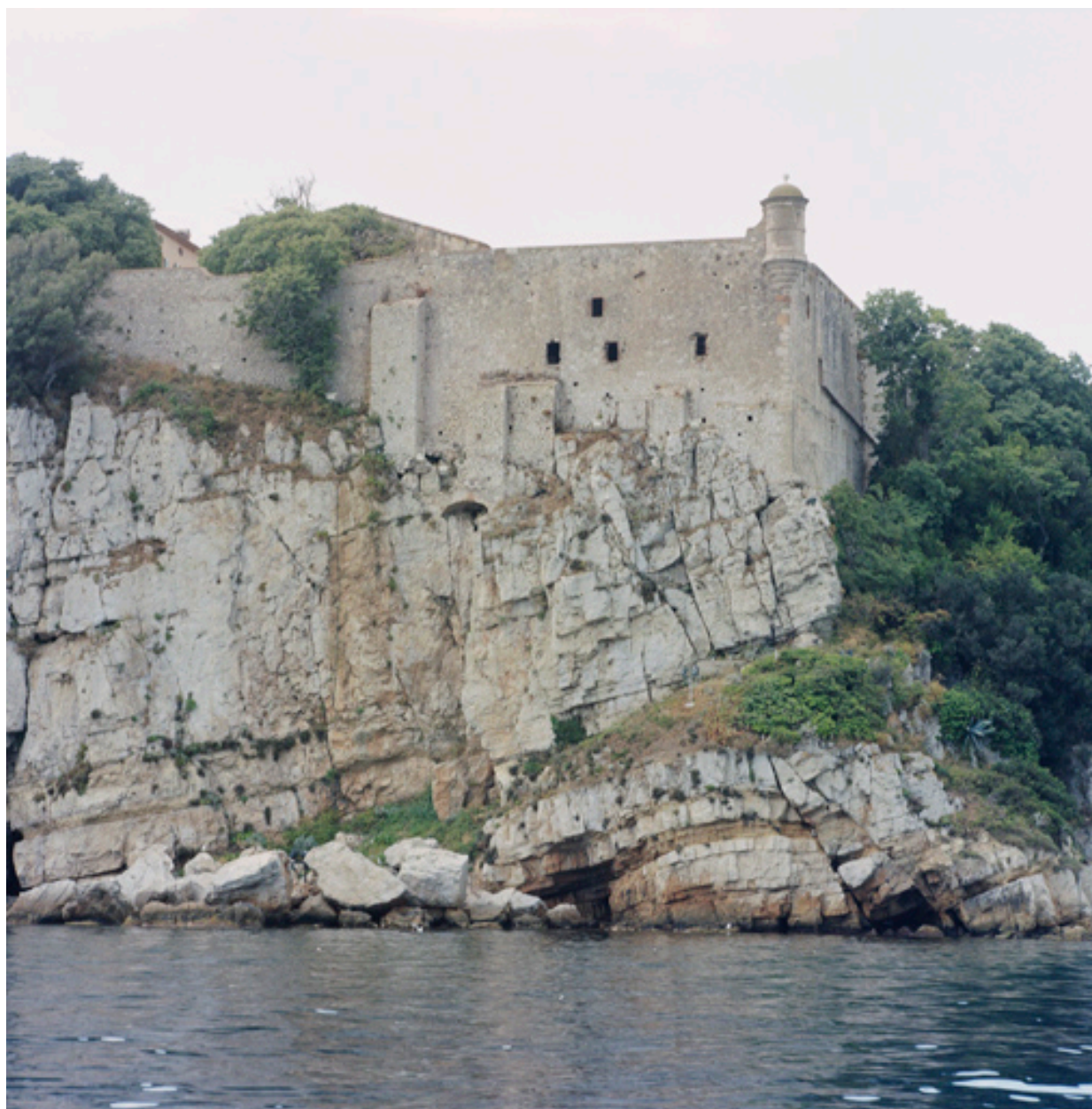
Partie ouest du front nord, maçonneries antiques remployées, échauguette.
