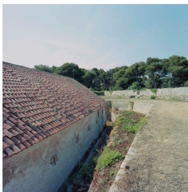
Magasin à poudres R dans le bastion H murs d'isolement et de terrassement.
