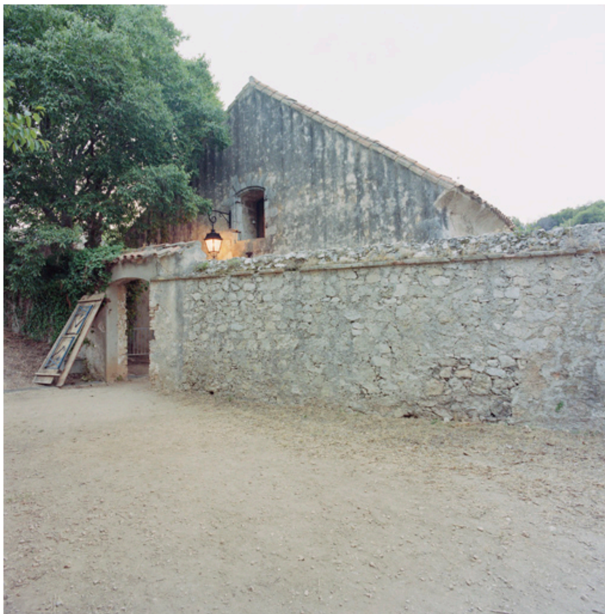
Façade d'entrée et mur d'isolement du magasin à poudres R.
