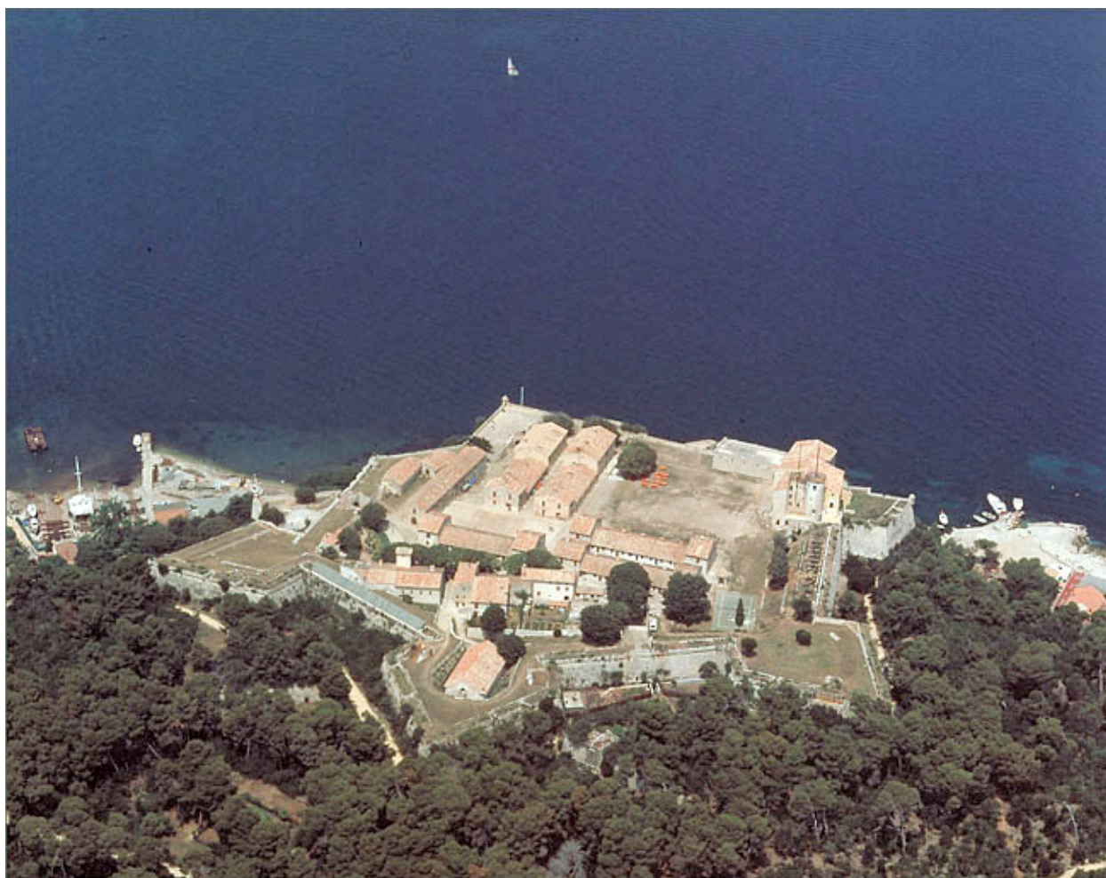
Vue aérienne prise du sud.
