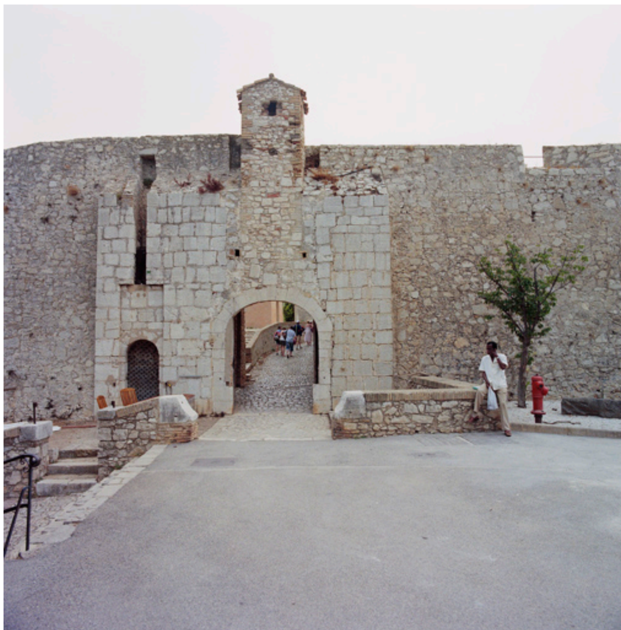
Façade extérieure de la porte Marine N.
