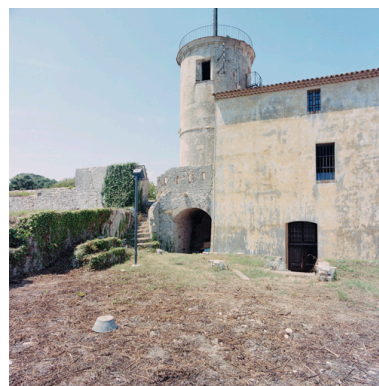
Courtine D, tour et partie de facade est du château A vues du bastion C. Phot. Marc Heller IVR93_20060600286XE
