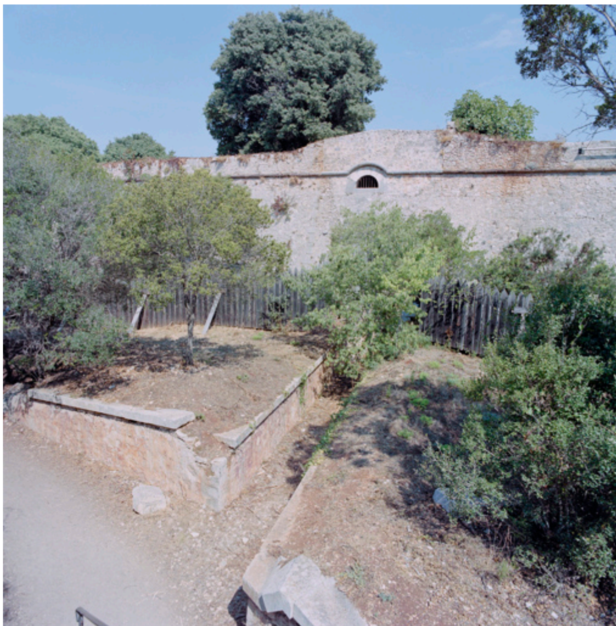
Emplacement de l'ancienne porte royale p dans la courtine G ; caponnière.
