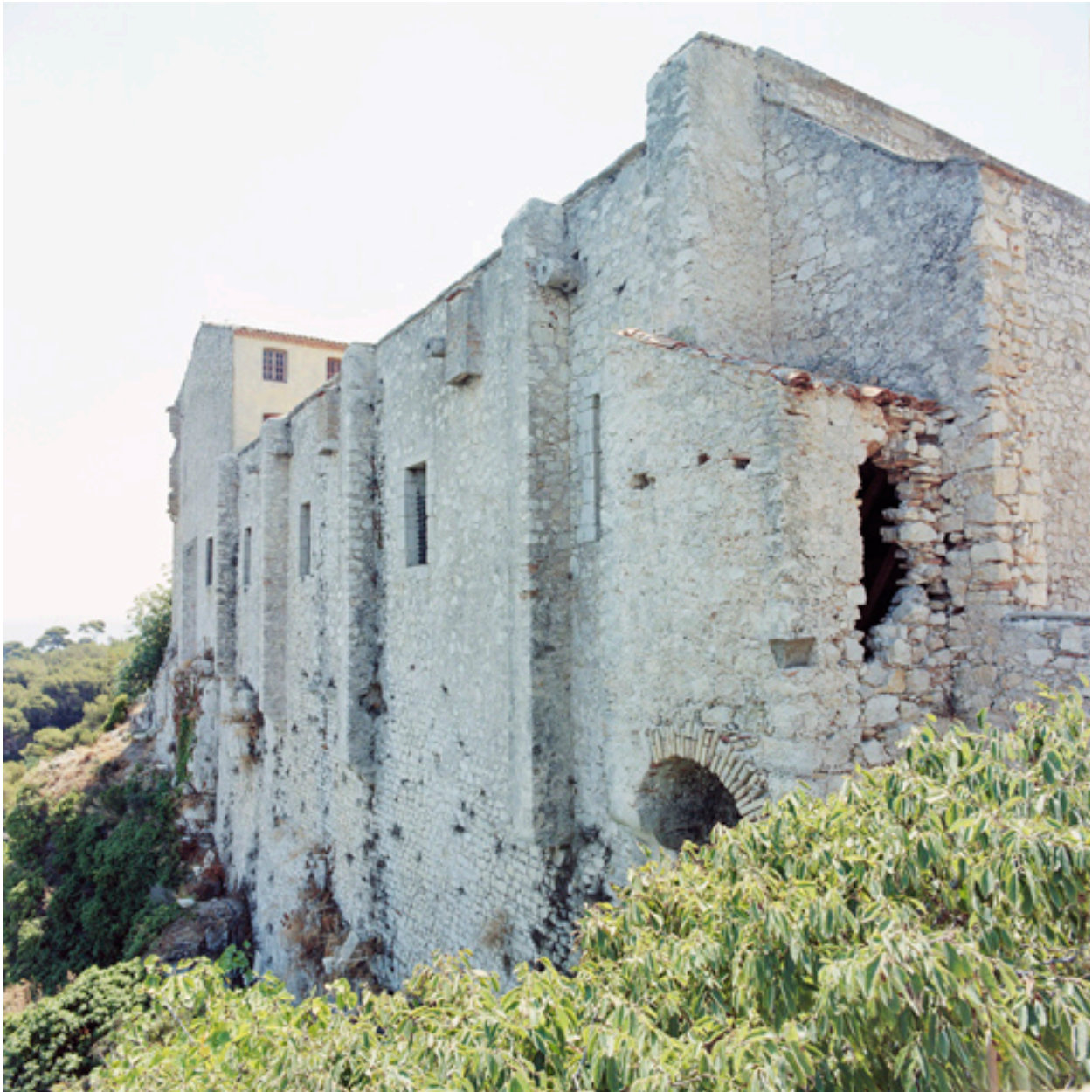
Façade nord de l'aile de la prison B et latrines, vues du redan du front nord.
