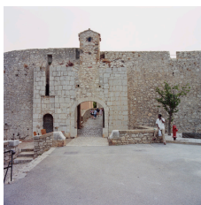
Façade extérieure de la porte Marine N.
