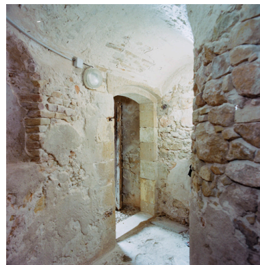
Couloir en chicane de la poterne sous l'abri voûté de l'ancienne porte royale p. Phot. Marc Heller IVR93_20060600298XE
