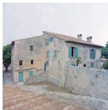
Les deux corps de maison du bloc W, vus de la rampe d'accès au bastion H. Phot. Marc Heller IVR93_20060600304XE
