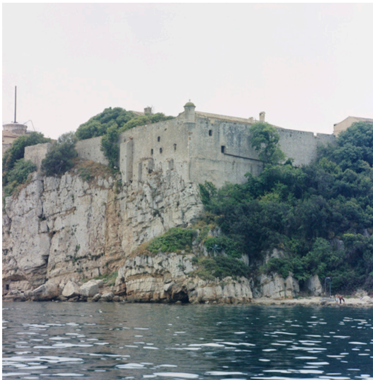
Vue de l'angle nord-ouest du fort, fenêtres de souterrains et échauguette.
