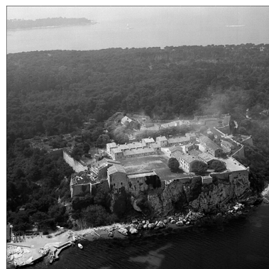
Vue aérienne prise du nord. Phot. Marc Heller
