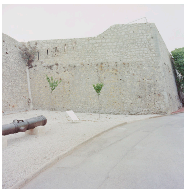
Flanc droit (nord) remanié du bastion L (Richelieu).
