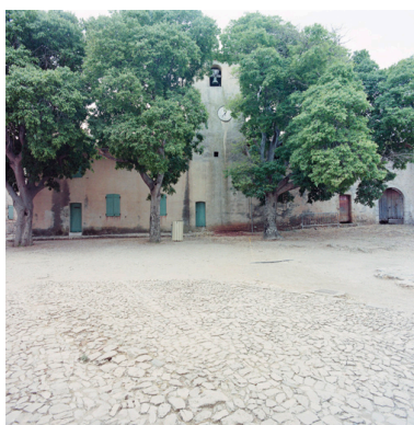
Façade nord du bloc Z du quartier sud-ouest, avec le clocher de l'église (a).
