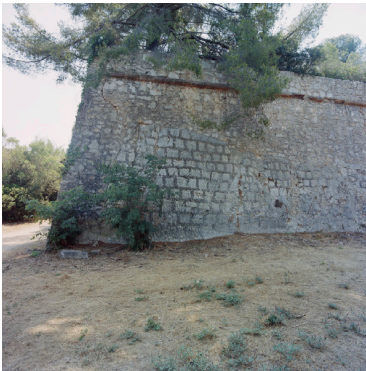
Détail du parement de la face droite de la demi-lune F.
