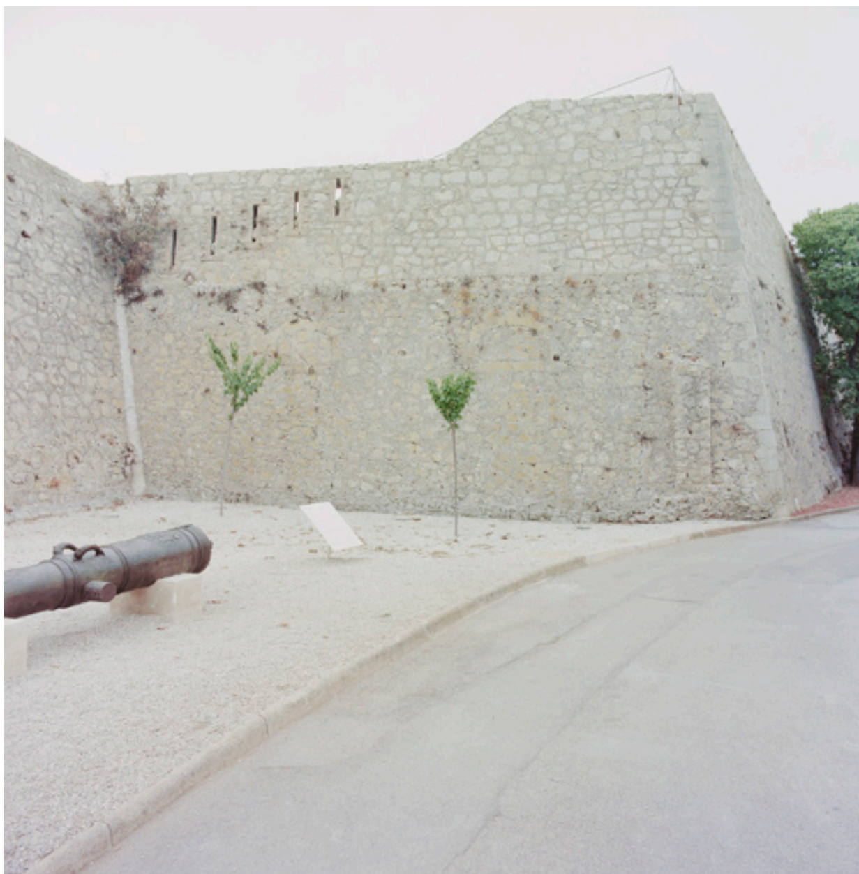
Flanc droit (nord) remanié du bastion L (Richelieu).
