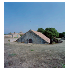
Magasin à poudres R dans le bastion H, vu du sud.
