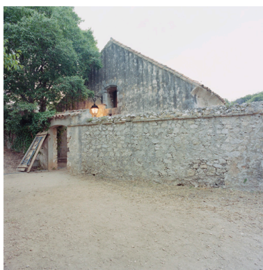
Façade d'entrée et mur d'isolement du magasin à poudres R. Phot. Marc Heller IVR93_20060600303XE
