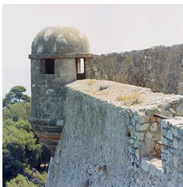
Détail de l'échauguette de capitale du demi bastion C, côté nord. Phot. Marc Heller IVR93_20060600285XE
