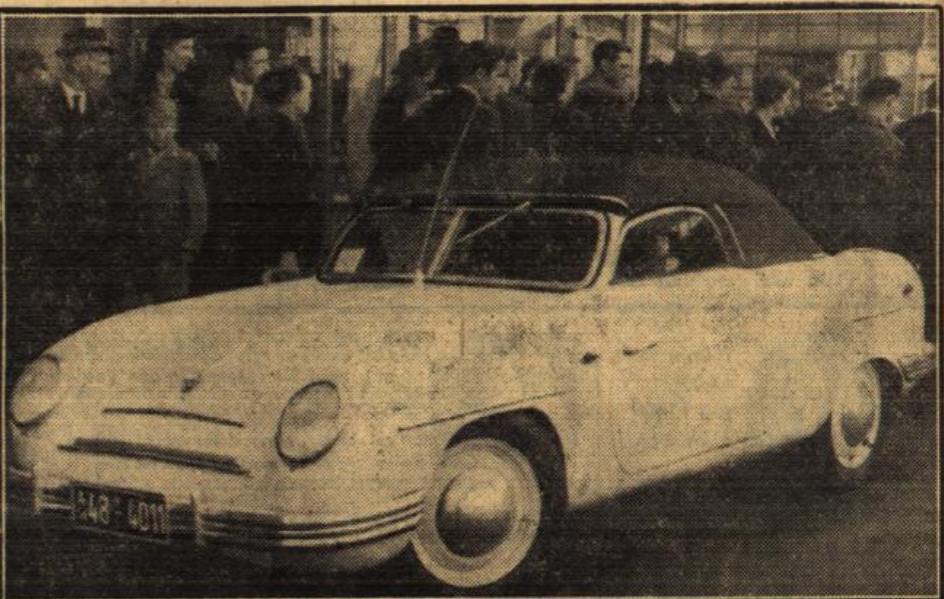
Volkswagen mit Spantekarrosserie aus Leichtmetallüberzug. Der mit dieser Karosserie versehene Volkswagen ist um 70 kg leichter als die normale Limousine. Durch die aerodynamische Form der Karosserie wird die Leistung des Wagens um 15% gesteigert. Weiterhin wurde durch eine Aenderung des Ansaugsystems und durch den Einbau von zwei Vergasern eine Höchstgeschwindigkeit von 140 Stundenkilometer ermöglicht. Die neue Karosserie wird bereits in Serienproduktion hergestellt.
