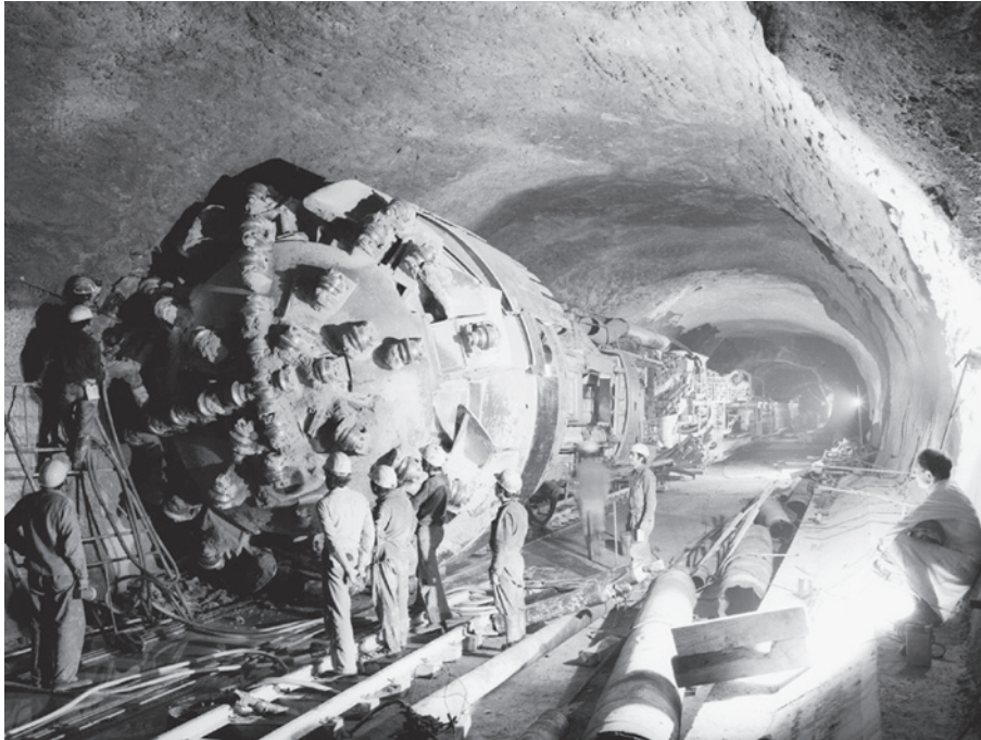
Photo 31—SPS, le 1er accélérateur entièrement en tunnel profond
