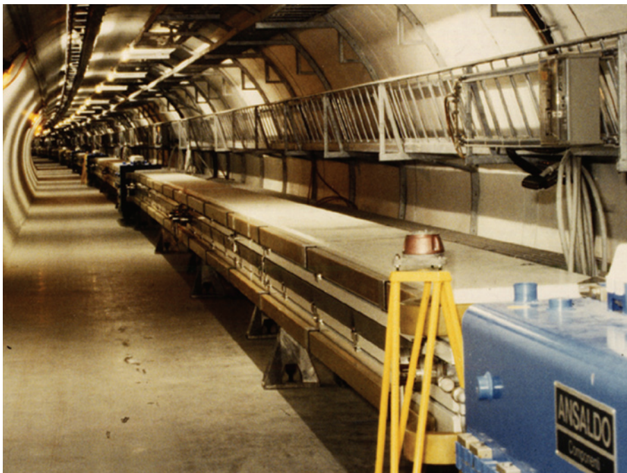
Photo 40—Les dipôles « en béton » (pour 80 %)
