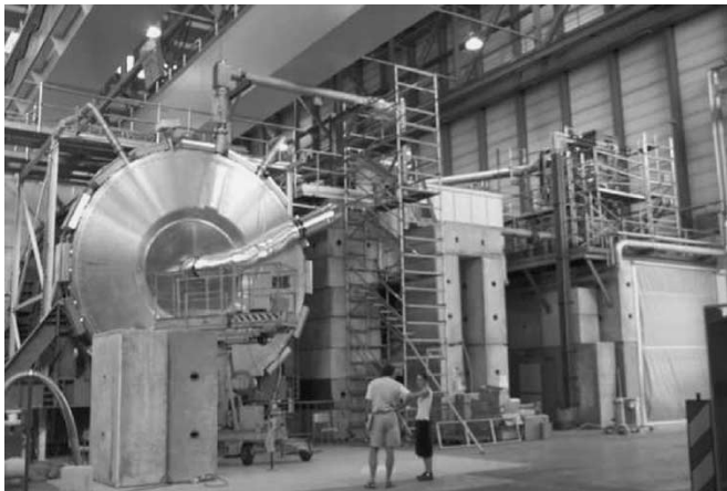
Fig. 4. On-surface installation (August 2003).
