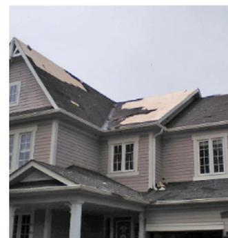
**Les dommages causés aux éléments non structureux – notamment le revêtement de toiture (la couverture) – sont l'un des aspects les plus fréquents dans les sinistres en cas de vent. Même des vents relativement modérés peuvent entraîner ces dommages, voire la perte de la couverture.**
