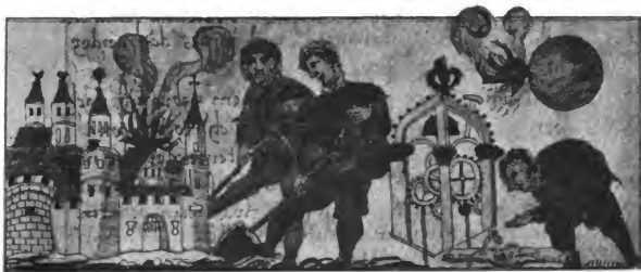
Abb. 69. Sprengwerke mit Zeitzündung.
