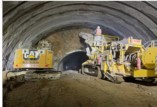
高屋トンネル(切羽掘削状況)
