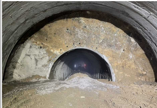
高屋トンネル(切羽写真)
