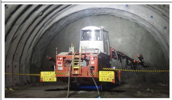
新及位トンネル（削孔状況）
