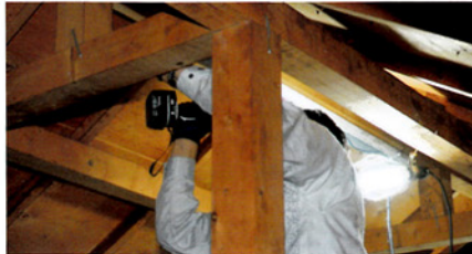
作業をしやすくするため、まず棟木に蛍光灯を取り付ける
