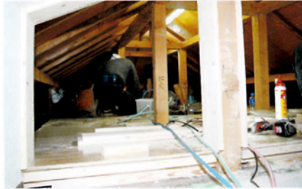
既存のグルニエとの接続部は化粧板で飾り付ける。床はほぼ敷き終わった
