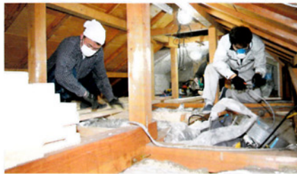
よく見ると小屋梁のほかにも梁をいくつも追加している。力を分散させ床を沈ませないためだ
