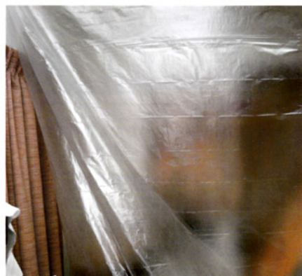
石膏ボードの粉が舞わないように透明シートで仕切る
