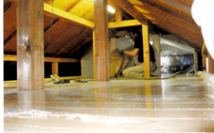
電気の配線工事も終え完了。朝8時から始めて午後5時にこの状態となった
