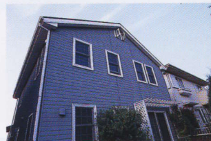
↑ 屋根のすぐ下に新しく窓ができた
