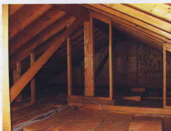
↑ 工事直前の様子。床は断熱材だけの状態だ
