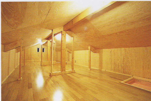
↑ 仕上がった屋根裏。合板の床は1帖当たり180kgの耐荷重がある
